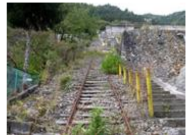
明延の廃鉱山跡に鉱石運搬用 インクラインが残る
