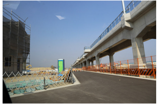
常磐線の復旧工事
