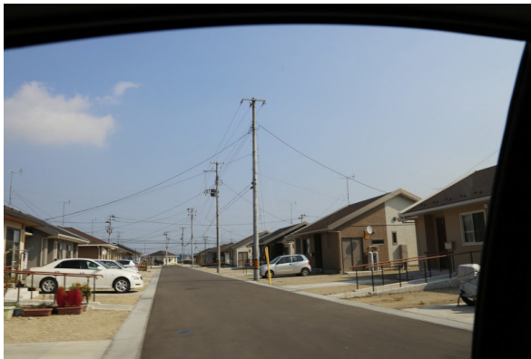
災害公営住宅
