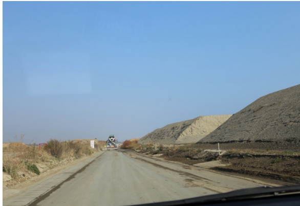
山元町の嵩上げ工事
