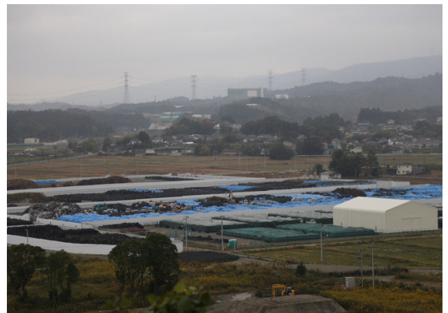
除染で発生した廃棄物の仮保管
