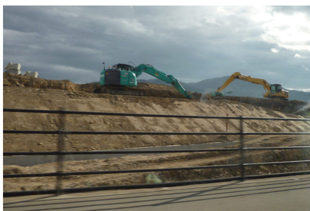
2016年12月時点の嵩上げ工事（陸前高田）
